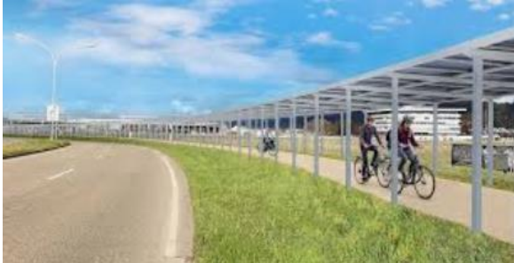
Fahrradweg mit aufgeständerter Fotovoltaik
